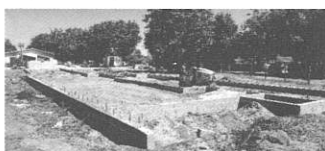
Lancement des travaux cet été
